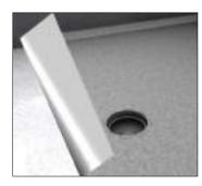
4- stendere la guaina sulle superfici pulite e già spalmate di apposito collante oppure spalmare le resine impermeabilizzanti
