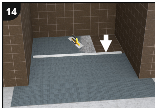
Rimessa della protezione in polistirolo, stesura della colla cementizio e posa delle piastrelle. Place another time polystyrene protection and spreading adhesive cement for tiles installation.
