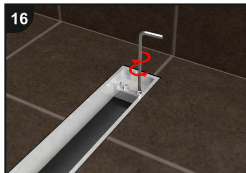
Regolazione in altezza della griglia con le 4 viti M6. Adjust grid height with the 4 M6 screws.
